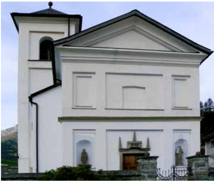
Die Kirche in Rona (GR) konnte restauriert werden, doch die Rückzahlung der Schuld gestaltet sich aufgrund sinkender Steuereinnahmen schwierig. (Foto: C. Poltera)
