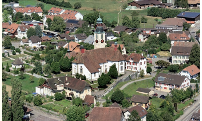
Pfarrkirche und Marienwallfahrtsort Oberdorf, SO
