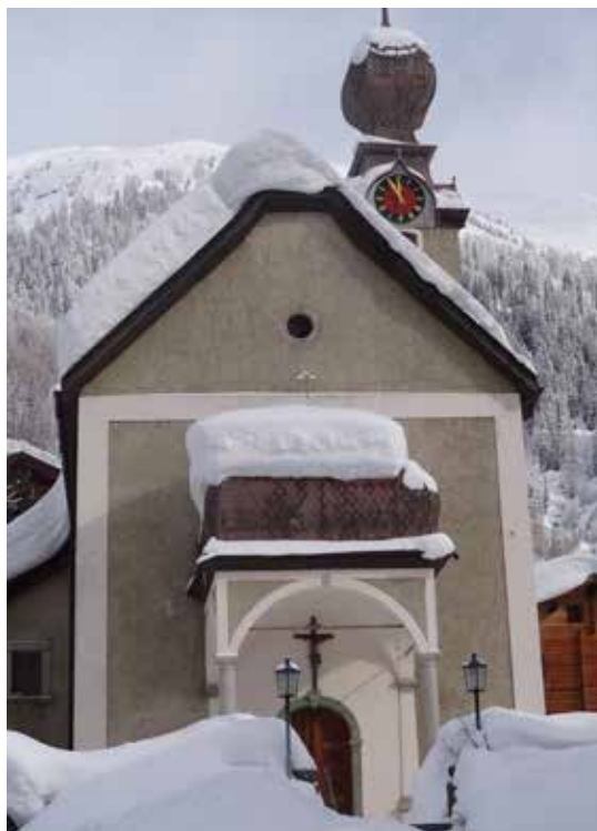
L'église paroissiale de Blitzingen, vallée de Conches.
