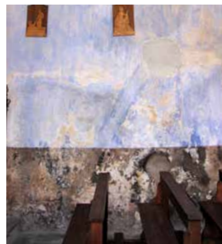
Certes, le chœur a pu être rénové il y a de cela quelque temps. Mais le vaisseau est dans un état désolant. Les murs et le crépi s'effritent. (Photos: Luca Invernizzi)
