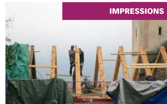
Le toit a été stabilisé et renforcé par des poutres robustes.
