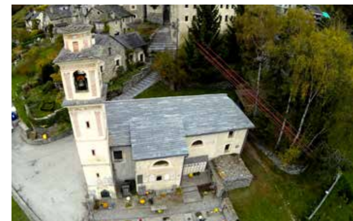
Le toit est assaini. Il s'agit maintenant de remplacer les tuiles du clocher et de repeindre la façade.
