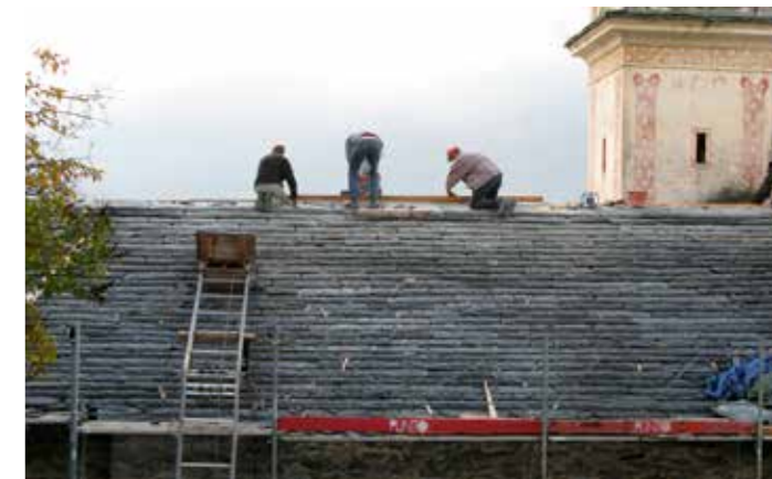
Tuile pour tuile a été remplacée. Le toit est à nouveau imperméable.
