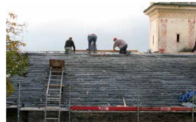
Ogni tegola è stata sostituita. Ora il tetto è nuovamente impermeabile.
